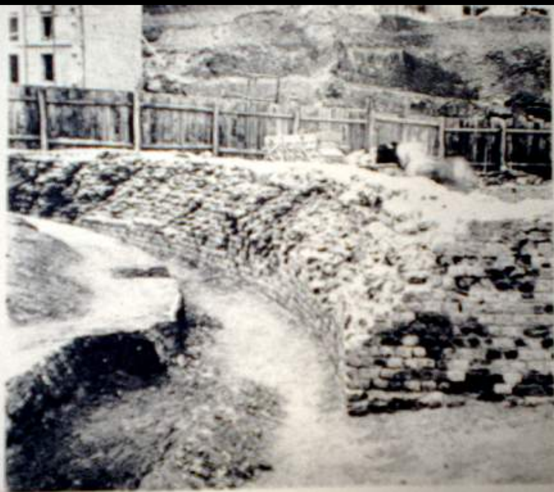
5. — Mur du Ponsu; dallage de pierre en avant du mur (partie Nord-occidentale, près de l'entrée du Nord).
