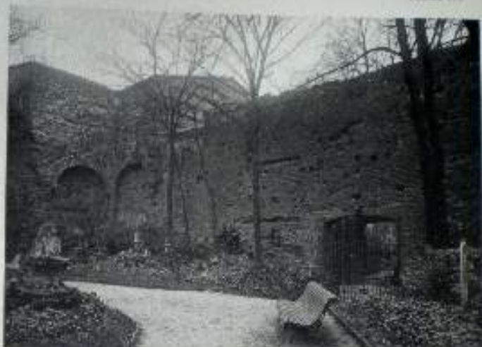
1. — Mur de l'enceinte de la ville de Cahors.
