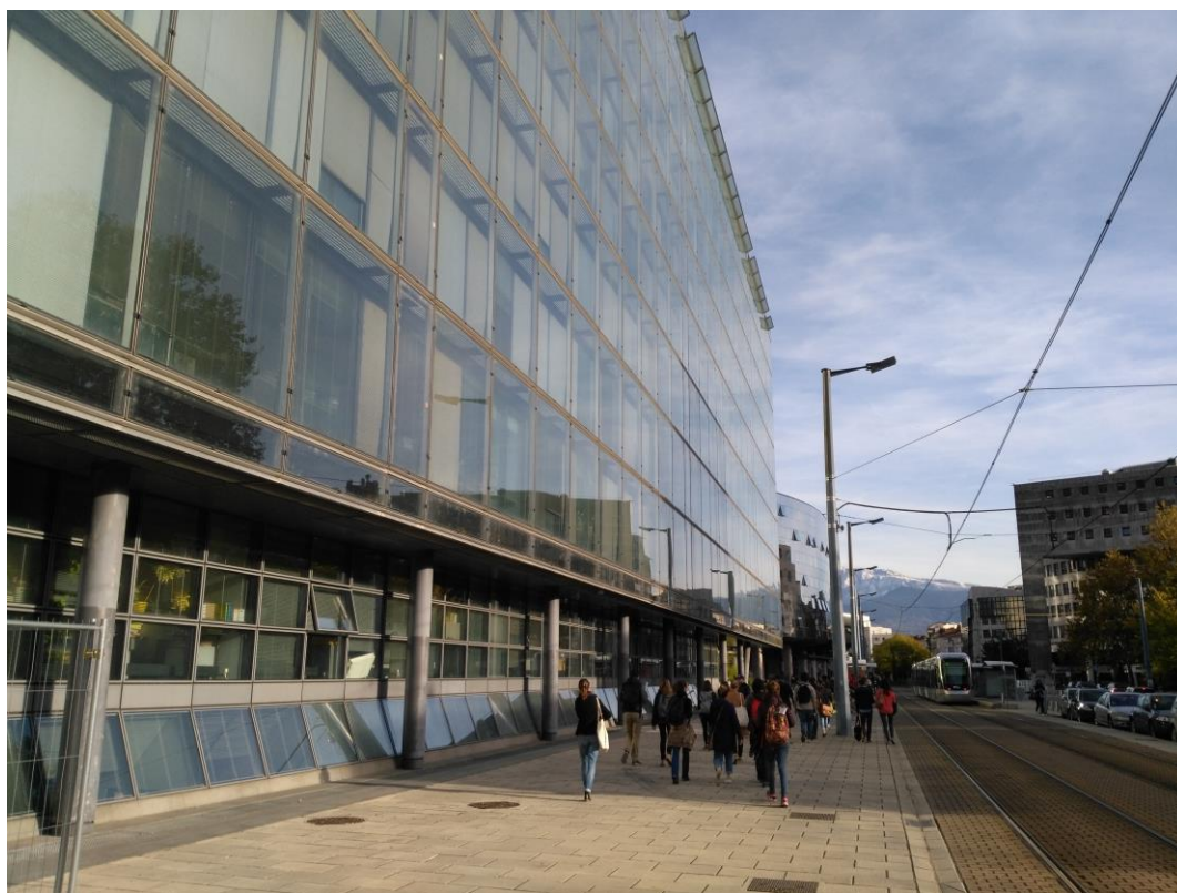
La ligne de tramway B passant le long du Palais de Justice
