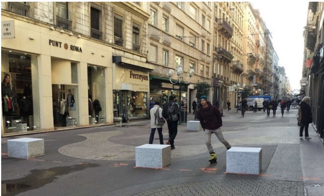
Figure 8 : Les blocs de béton installés dans la rue Victor Hugo pour protéger les usagers de la rue piétonne [ici, au début de la rue, en partant de la place Bellecour].
