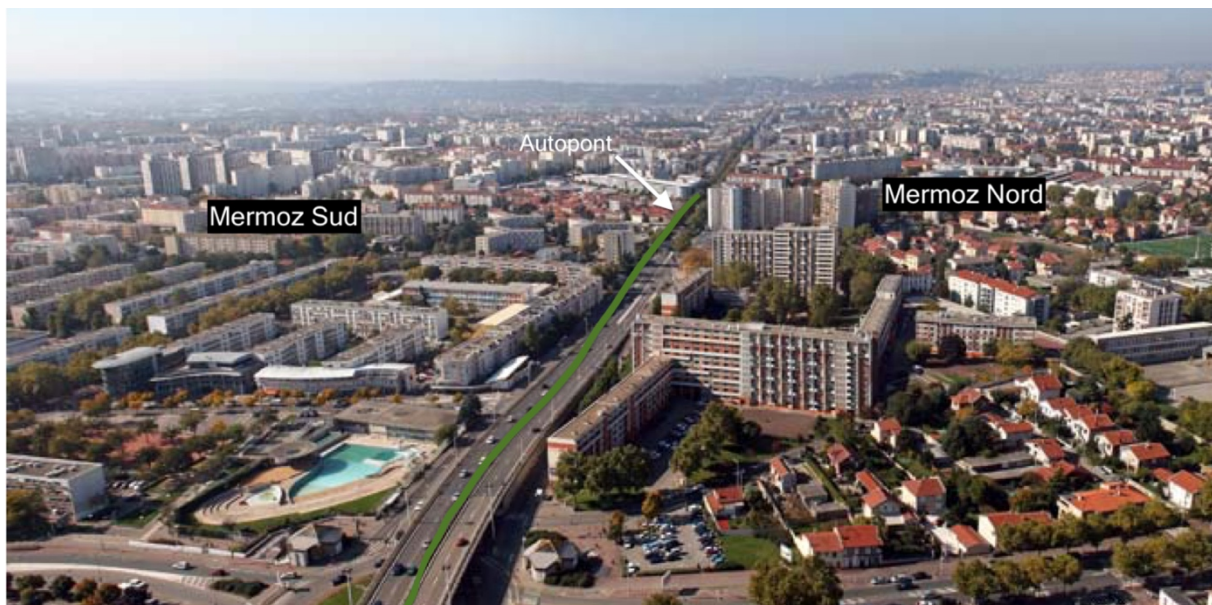
Figure 15 : Vue aérienne de Mermoz Nord et Sud avant les travaux de 2007
