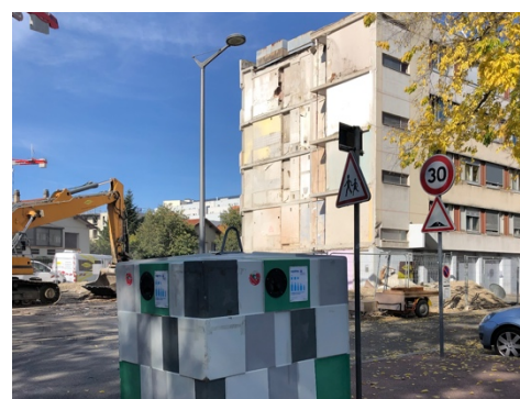
Figure 17 : Destruction d'une barre d'immeuble rue Gaston Cotte, Mermoz Sud
